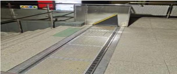
Este sistema de Anti-Inundaciones no requiere instalación eléctrica, se activa y desactiva automáticamente con la fuerza del agua.
