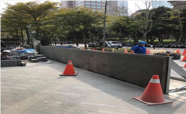
La compuerta Anti-Inundaciones cuenta con brazos hidráulicos que levantan la barrera del suelo, estos se activan pulsando un interruptor. La barrera cuenta con una batería que permite que funcione hasta 10 horas sin suministro eléctrico.
