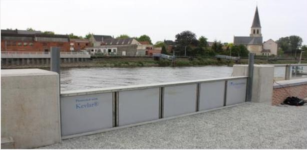
Este sistema de protección contra inundaciones se instala debajo del suelo y se eleva automáticamente con la llegada de agua.
